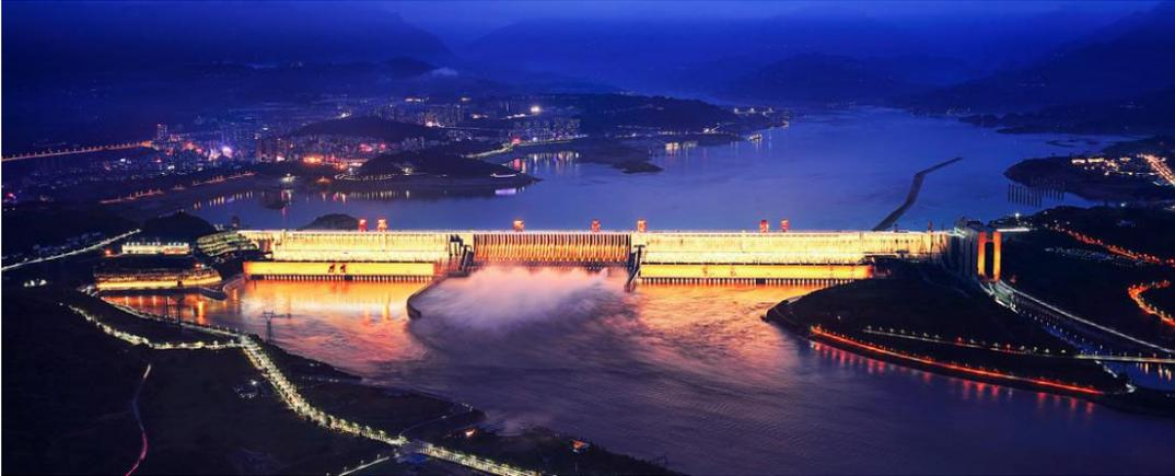
三峡大坝位于湖北省宜昌市三斗坪镇，下距葛洲坝 40 公里，整个工程由拦江大坝、水力发电厂和通航船闸组成，拦江大坝建在中堡岛上。三峡水利枢纽是综合治理与开发长江的关键性工程，三斗坪一带河床开阔，两岸花岗岩基坚硬、完整，所以长江三峡工程选址在这里。长江三峡工程竣工后，将发挥防洪、发电、航运、养殖、旅游、保护生态、净化环境、开发性移民、南水北调、供水灌溉等十大效益，其中年均发电量可达 849 亿度。
